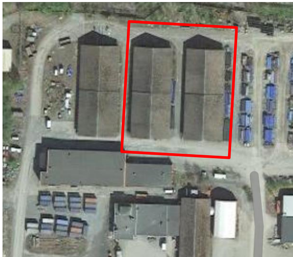
Rakennukset ilmakuvassa (google.com/maps), vasemmalla oleva halli on purettu
