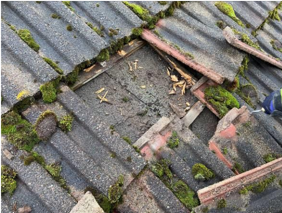
Vesikatolla painuma, jossa ruoderimoitukset lahonneet, tiilet alkaneet rapautumaan
